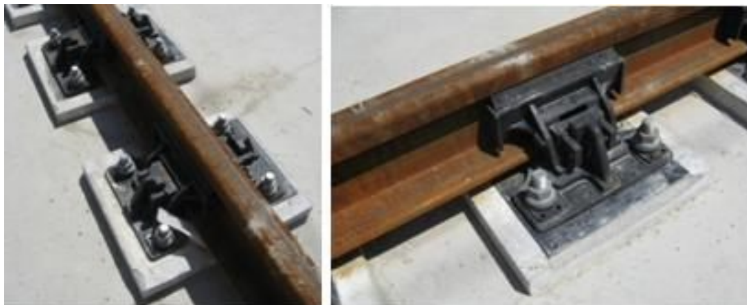
Slika 11. Sistem pričvršćenja koji pridržava vrat šine (Vanguard – Pandrol sistem pričvršćenja, snimljeno u stanici Beograd Centar, 2016)
